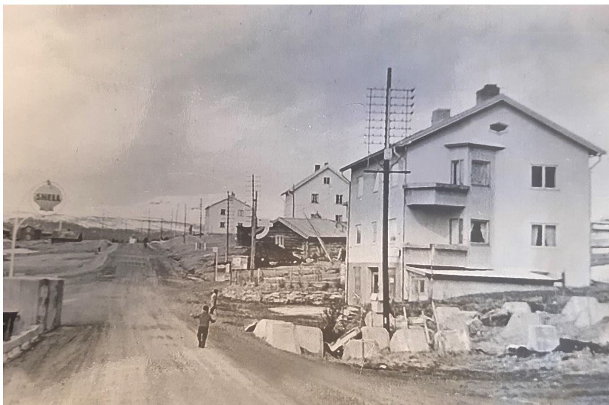
Glest placerad efterkrigsbebyggelse i Funäsdalen. Byggnaden till höger, ännu välbevarad, ligger inom Funäsdalen 30:11. Planen förses här med ny byggrätt samt medger rivning. Gårds- och säterarkivet.
