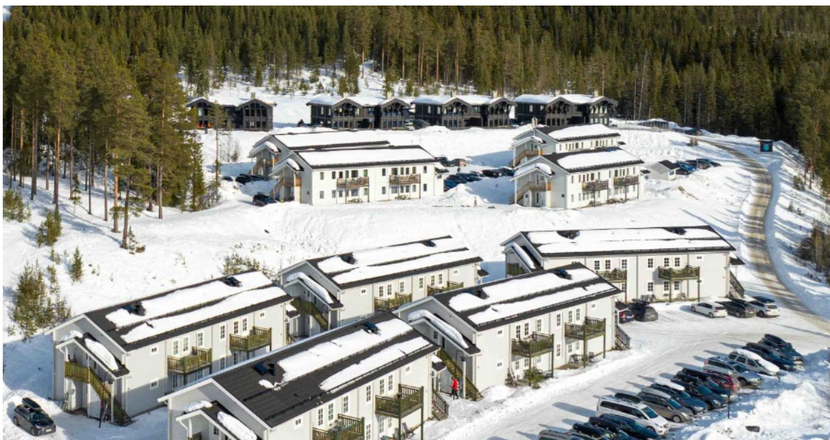
Foto 1 Befintlig bebyggelse inom område A1 idag. Foto: Lofsdalens fjällanläggningar AB
