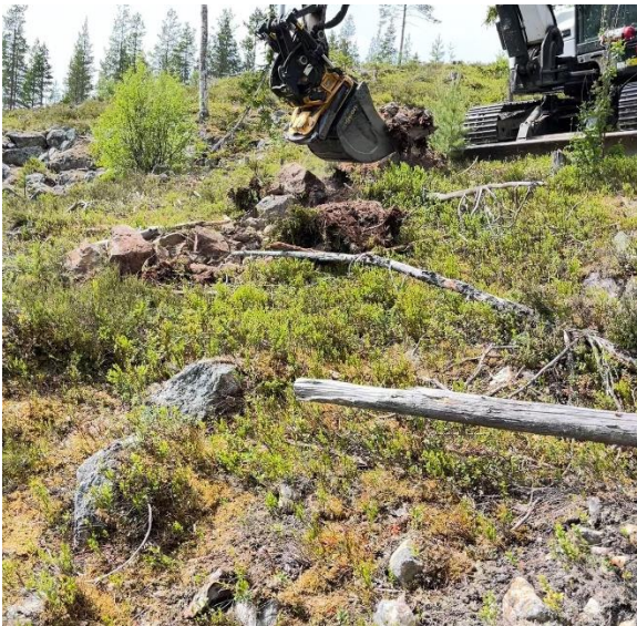
Figur 6.3 Ytlig block vid södra slanten.
